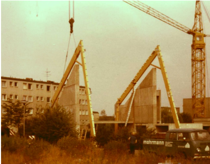
Kirchbau in der Dresdenstraße 203
